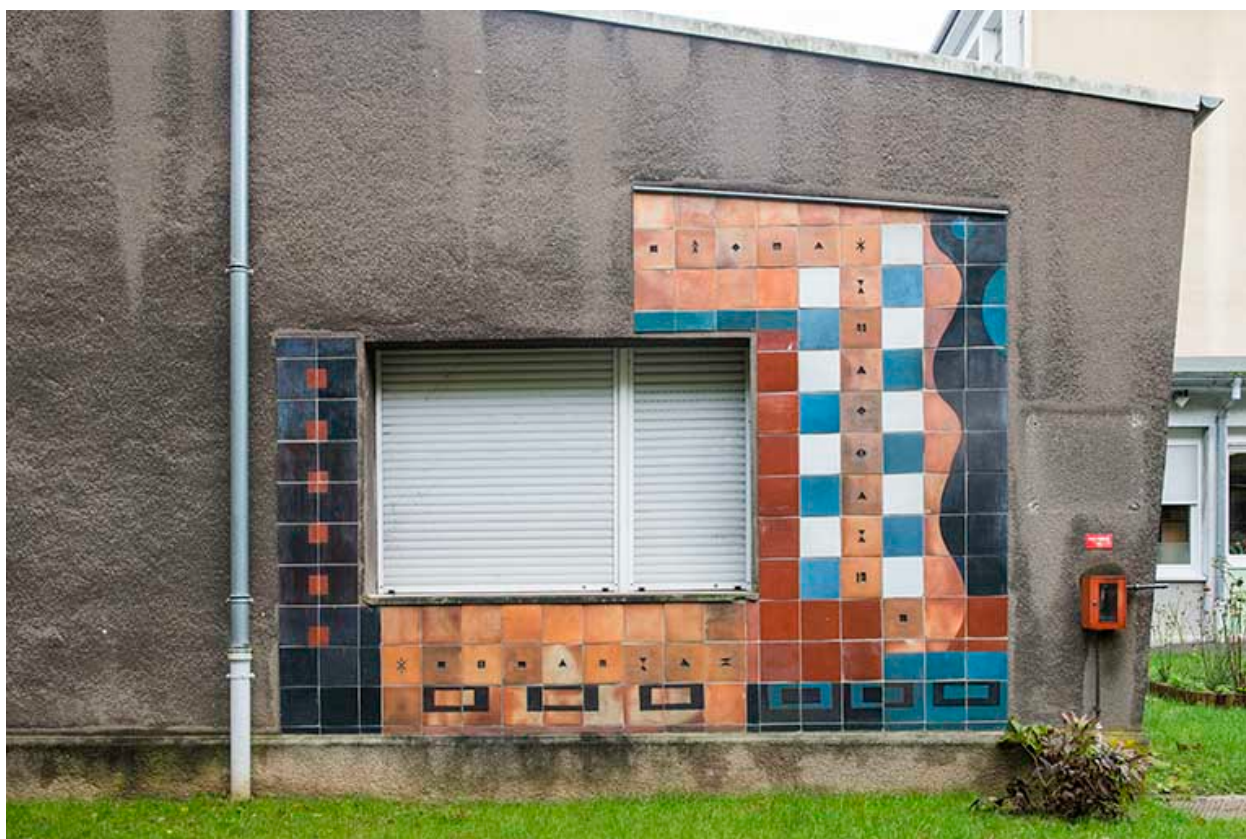
Oeuvre de Bizette. Façade sur rue.
