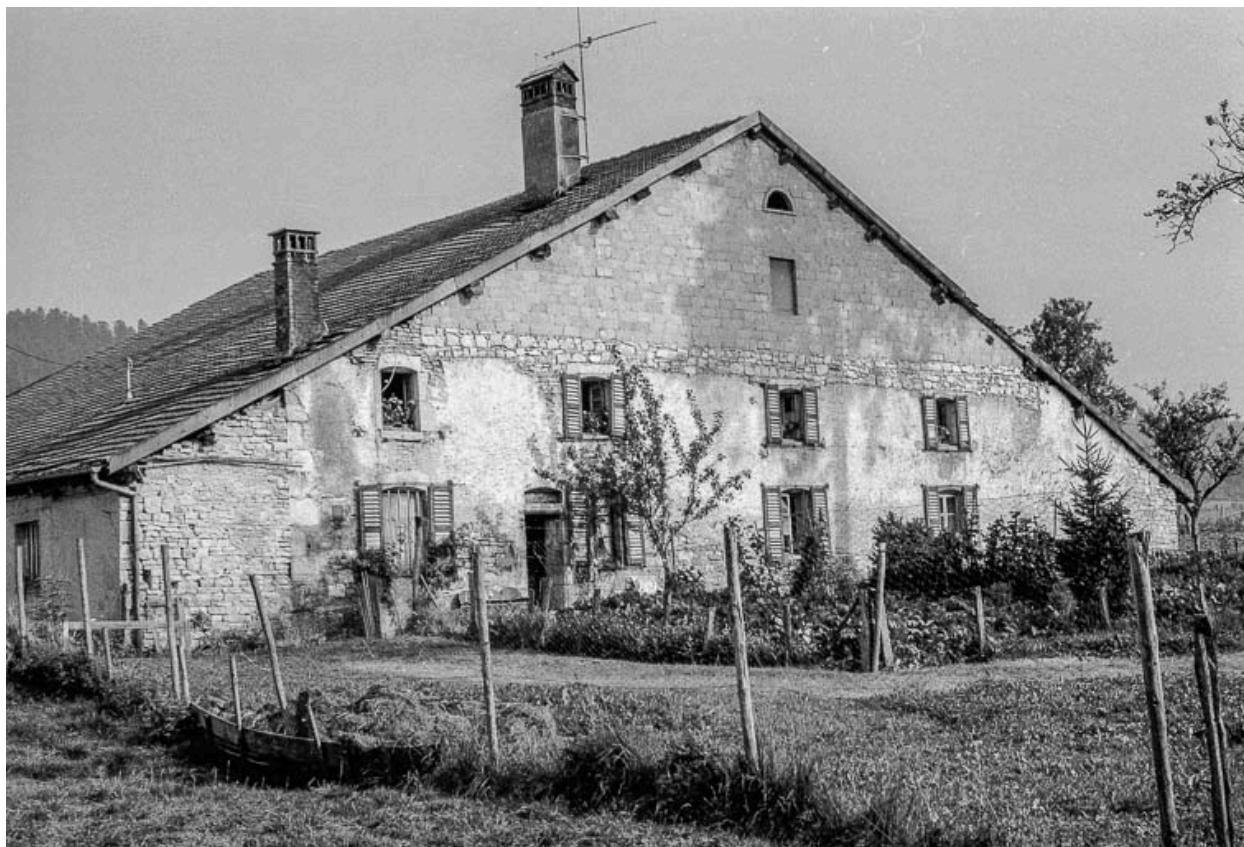
Ferme : façade antérieure vue de trois quarts gauche.
