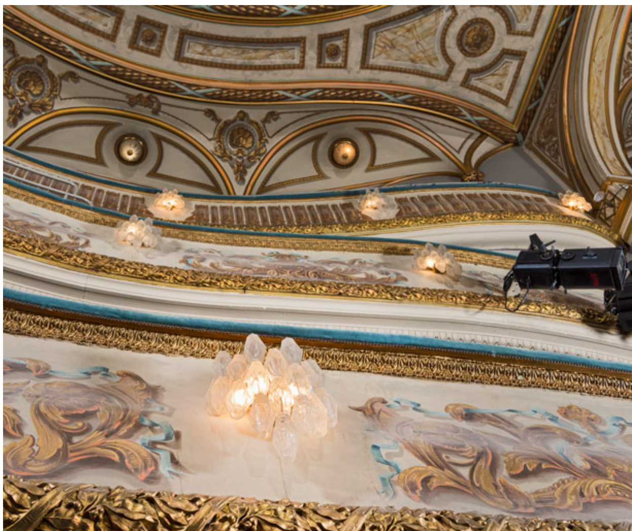
Luminaires d'applique sur les garde-corps des balcons.
