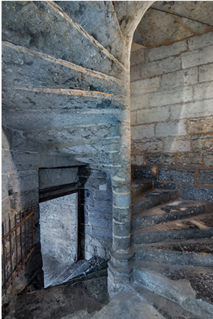
Escalier en vis : départ de la cave.
