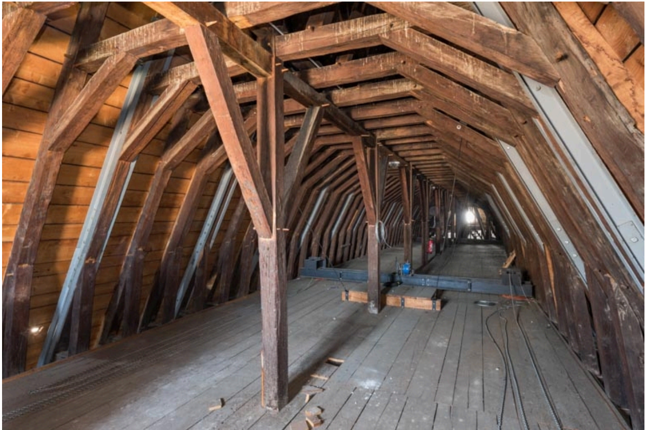
Comble : vue de trois quarts, prise en direction du chevet oriental.
