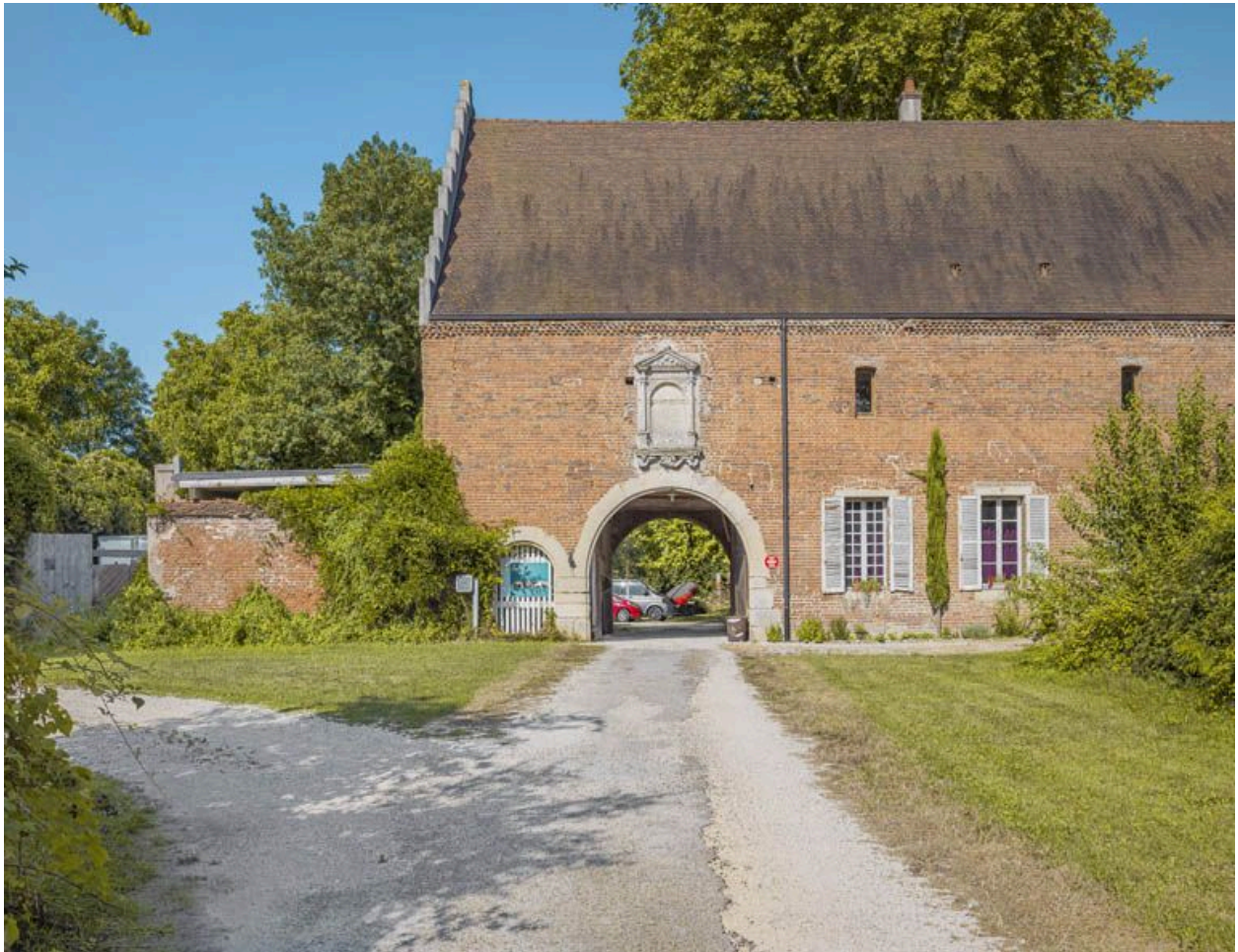
Bâtiment de l'ancien château : passage d'entrée, côté rue.
