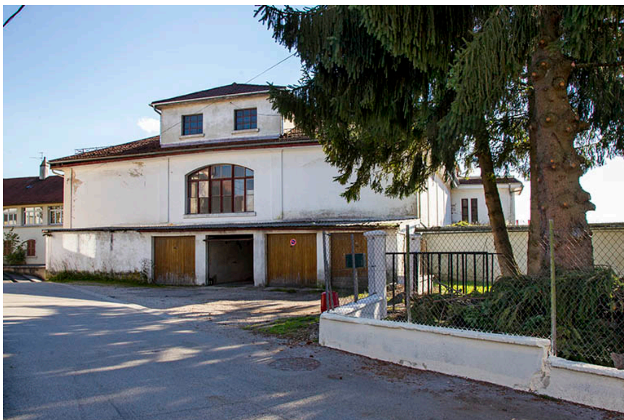
Bâtiment nord : façade latérale droite.
