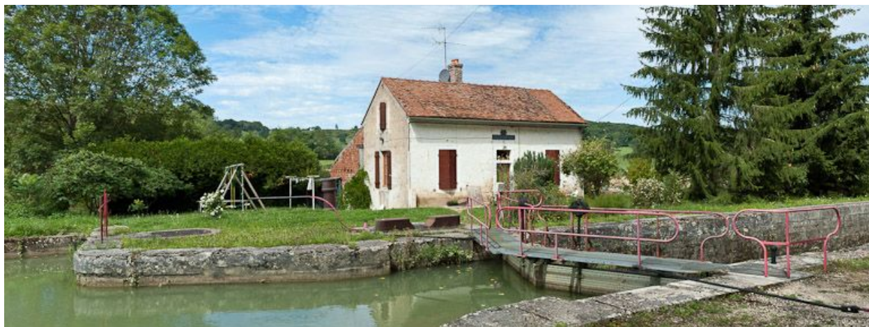
Vue d'ensemble du site d'écluse.
