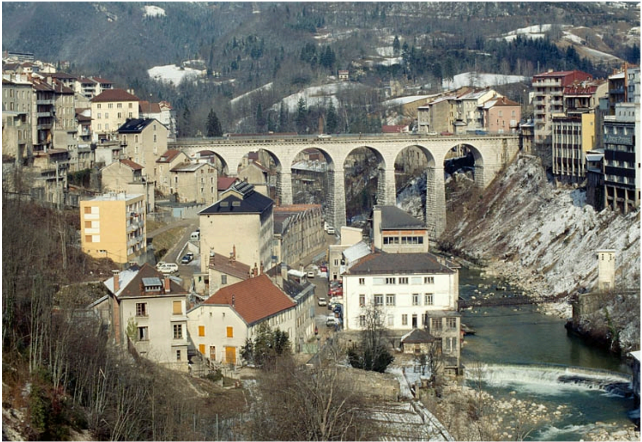
Vue d'ensemble du site depuis le sud.
