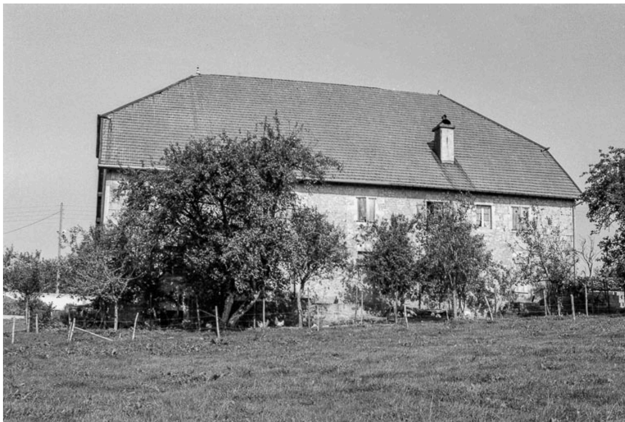
Ferme cadastrée 1961 AB 42 : vue d'ensemble.
