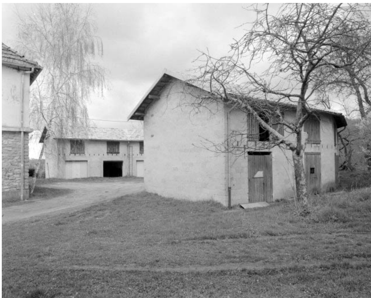
Remise d'automobile et bûcher (F) : vue d'ensemble.
