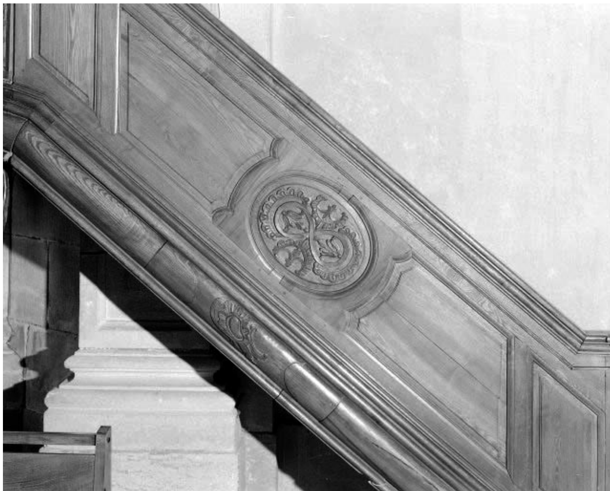
Détail : la rampe.
