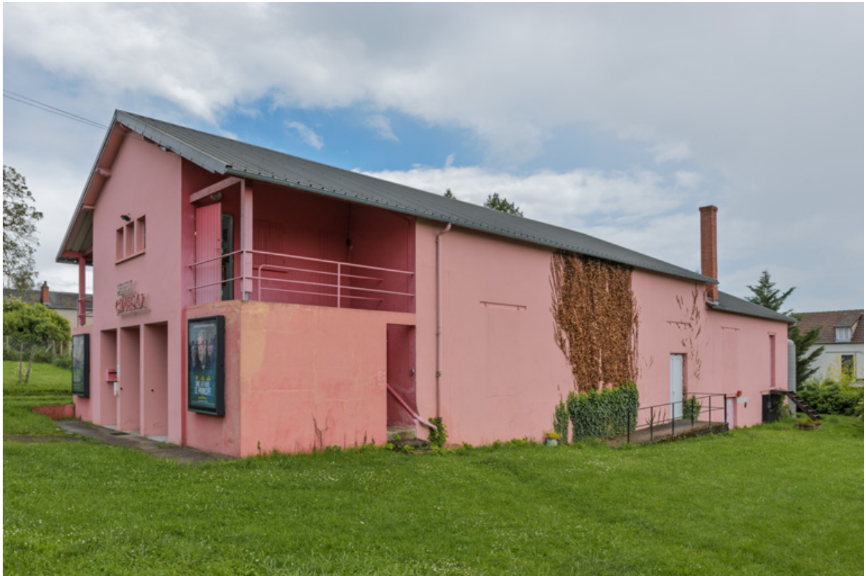
Façades antérieure et latérale droite.
