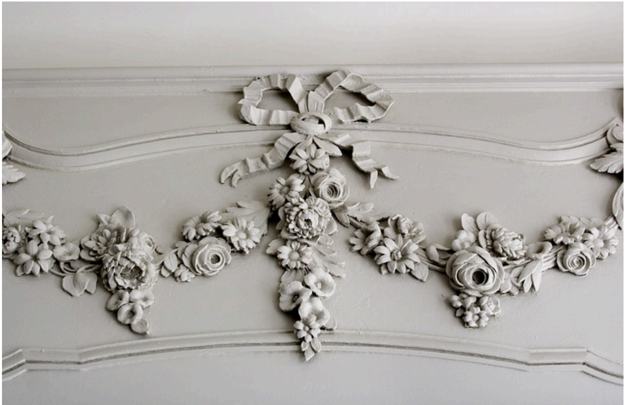
Intérieur, rez-de-chaussée : détail d'une grande guirlande de fleurs, lambris du salon.
