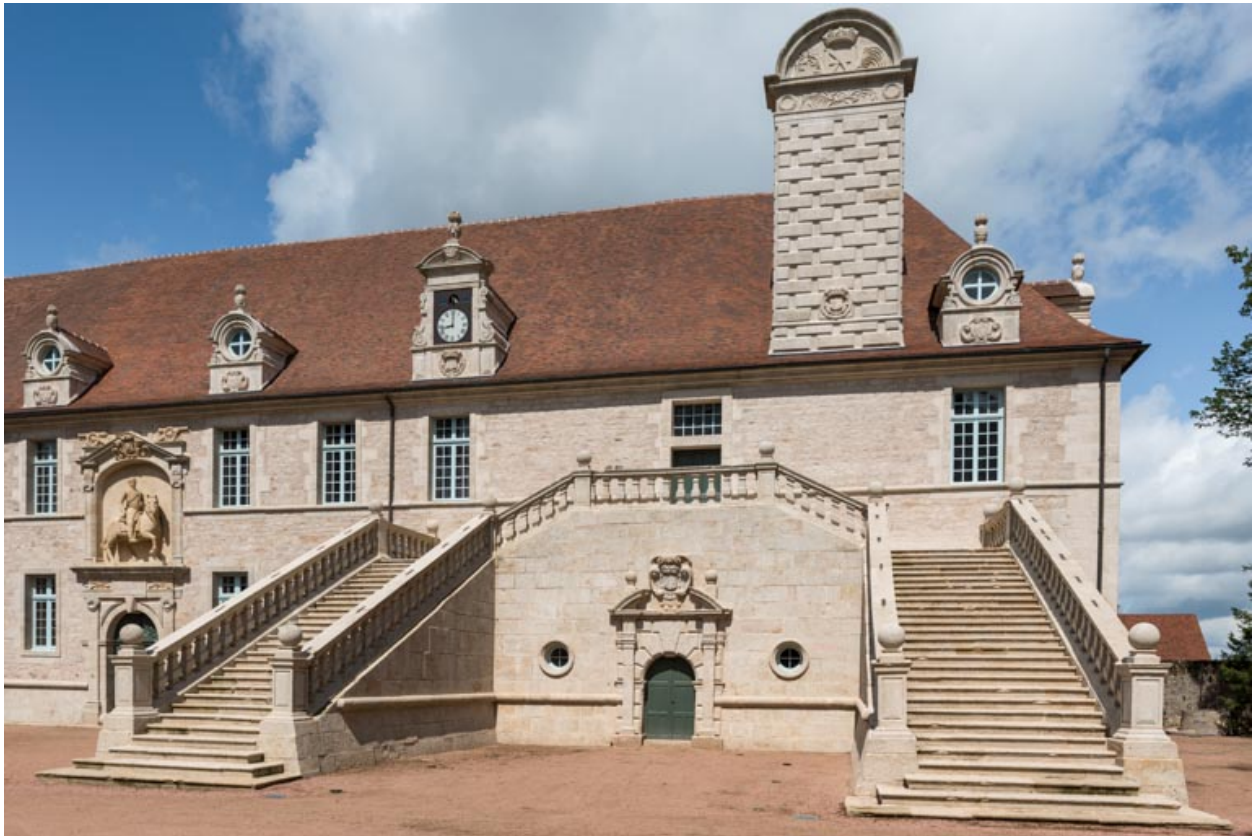
Façade sud-est, partie droite, grand-degré.
