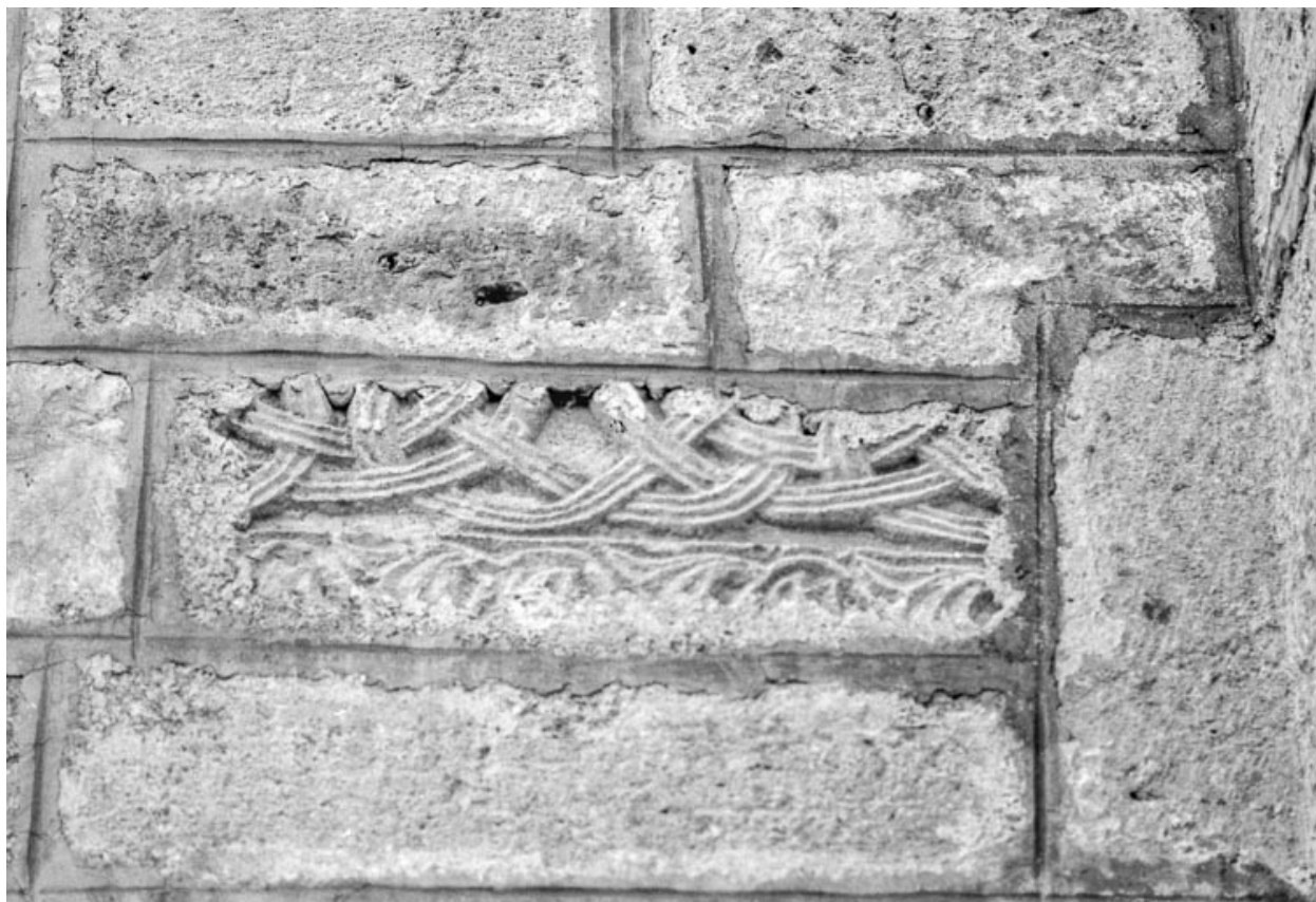
Extérieur : détail mur droit de la nef.
