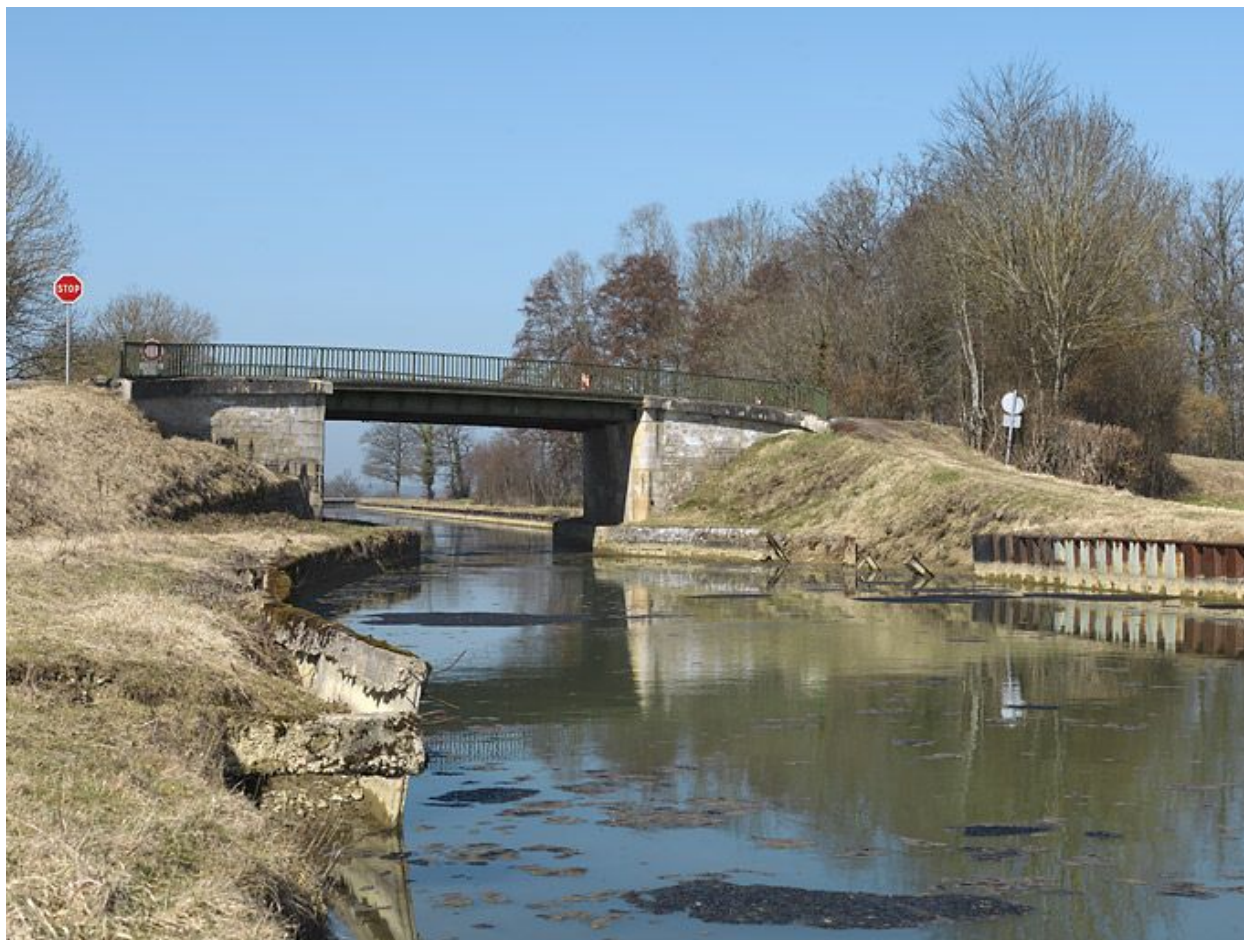
Vue d'ensemble du pont.
