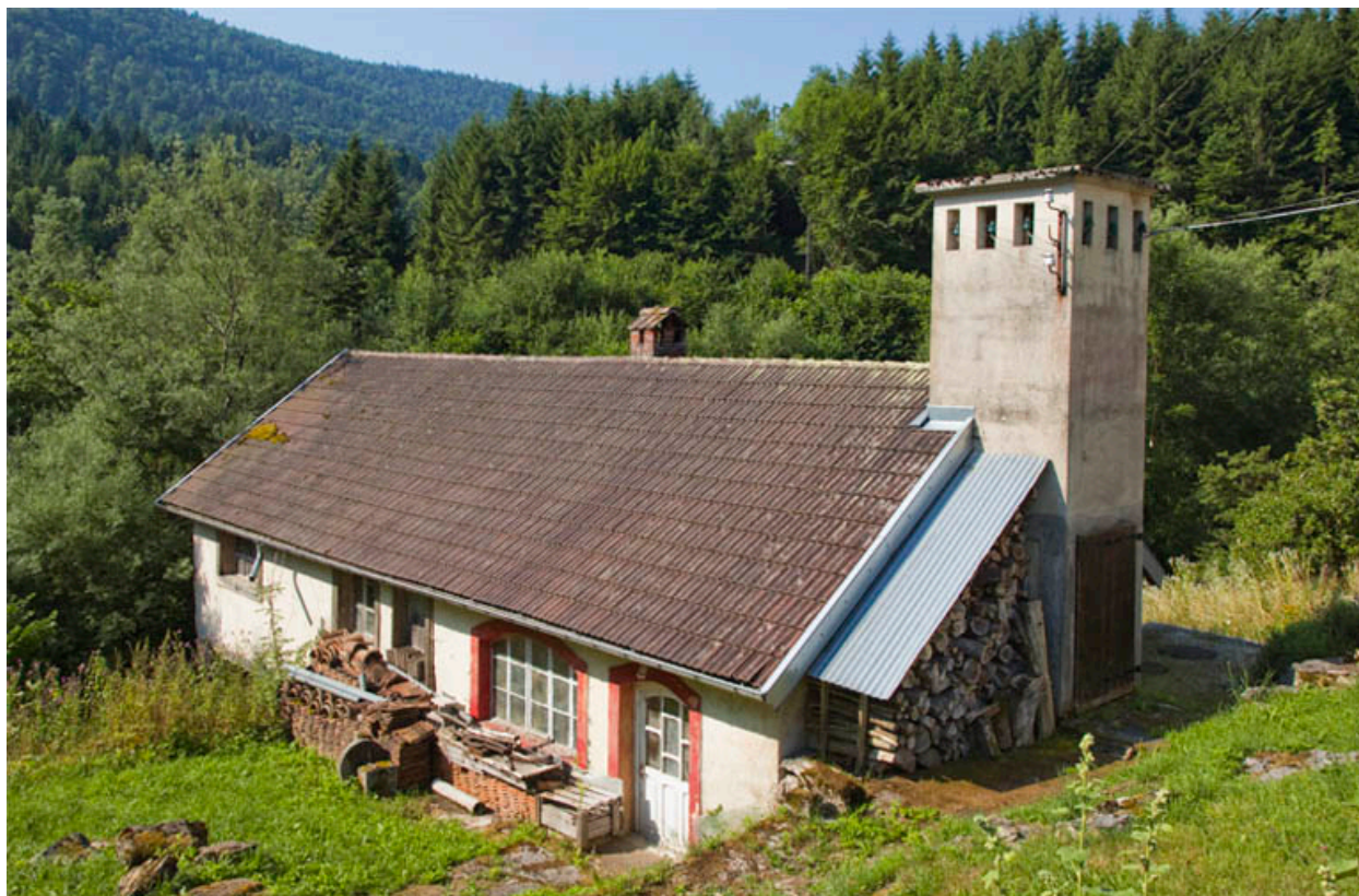
Scierie Renaud puis centrale hydroélectrique Huot-Marchand, Battenans-Varin.
