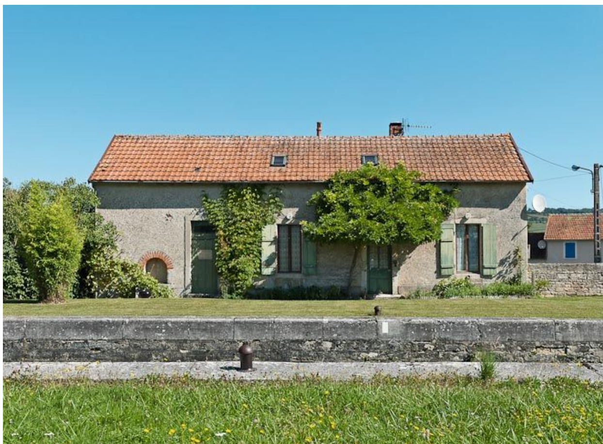
Vue de face de la maison éclusière.
