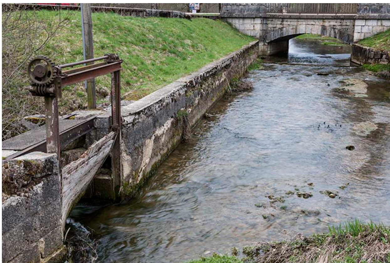
Canal d'amenée et vanne de décharge.
