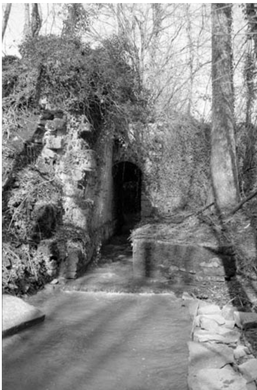
Coursière au débouché du bassin de retenue.
