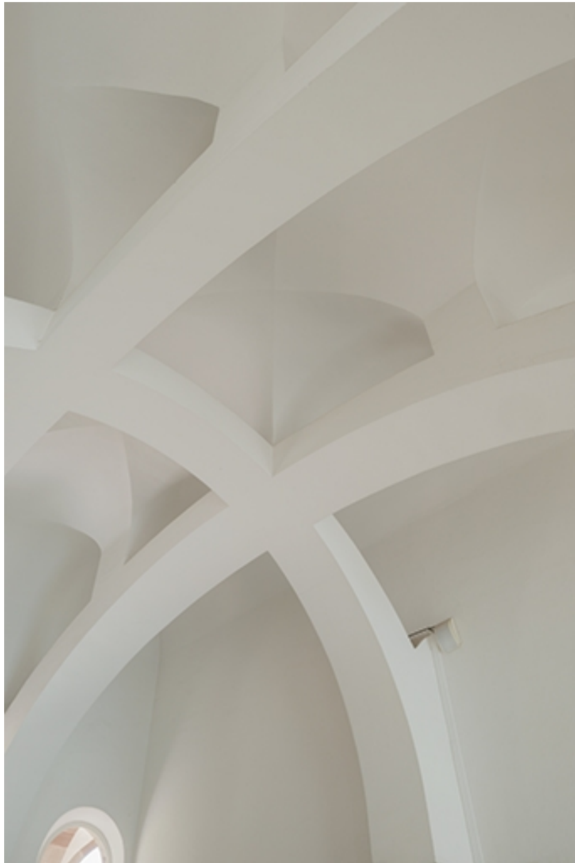
Vestibule nord à l'emplacement du Bain des Cuvettes, voûte.
