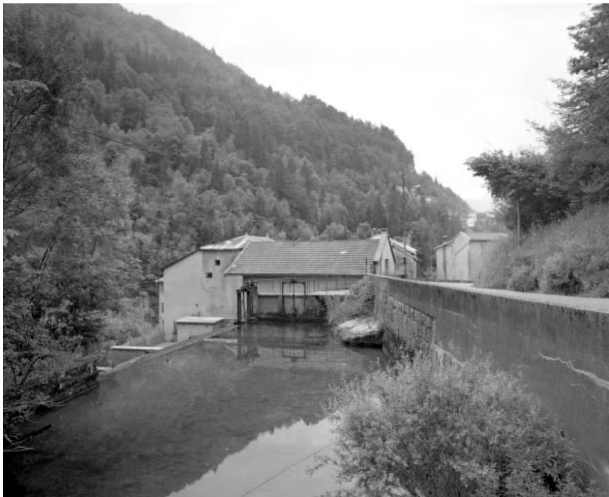
Barrage et prise d'eau vus de l'amont.
