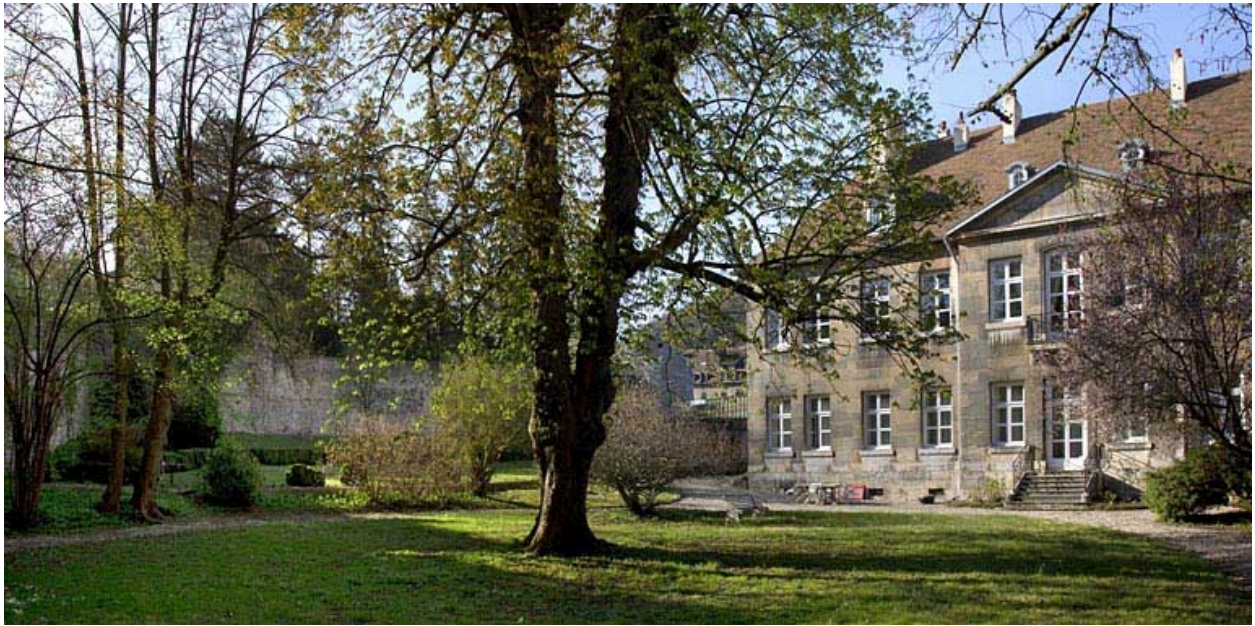
Vue de la partie gauche de la façade postérieure depuis le fond du jardin.
