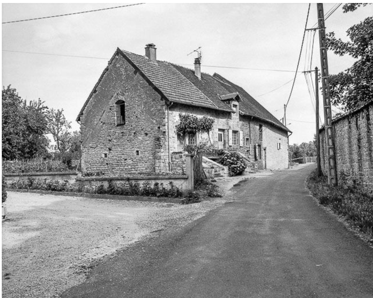
Chilly-le-Vignoble : maison de vigneron.
