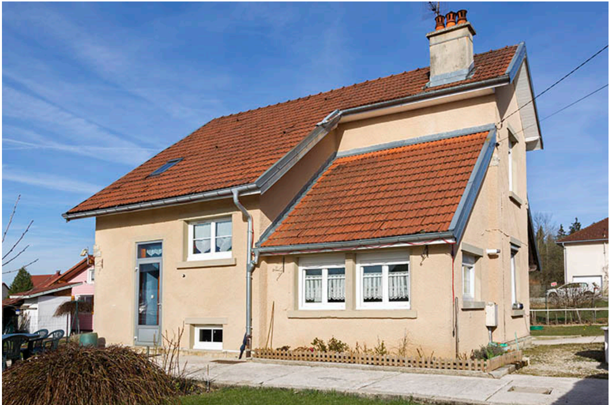
Façades antérieure (pignon) et latérale gauche.
