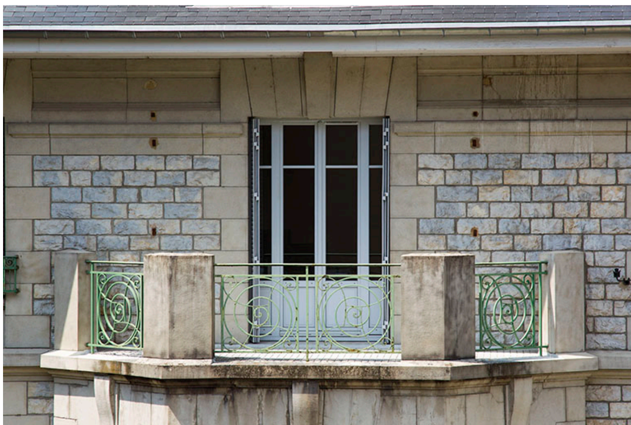
Façade latérale gauche : terrasse surmontant le bow-window.
