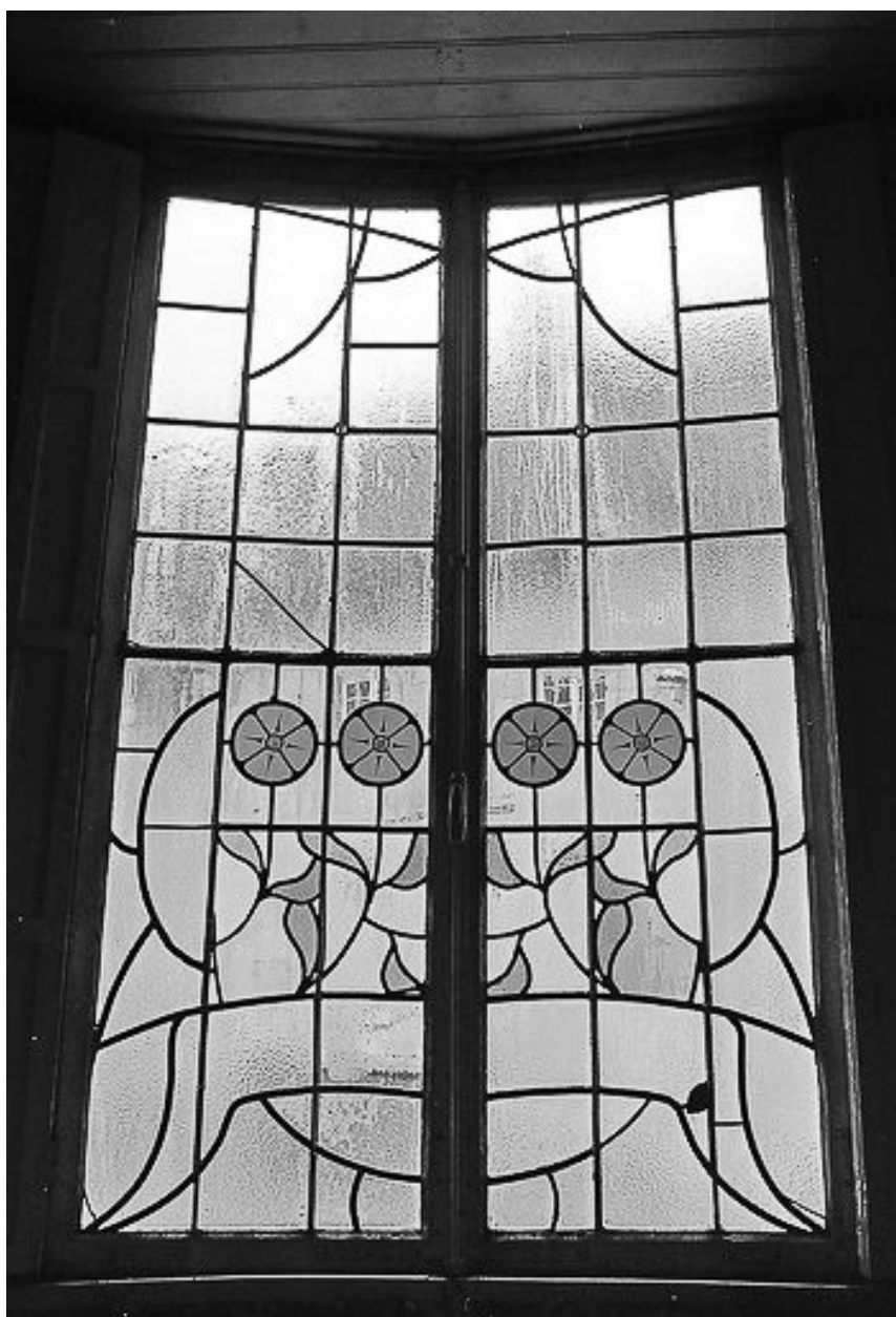
Baie cintrée vue de l'intérieur.
