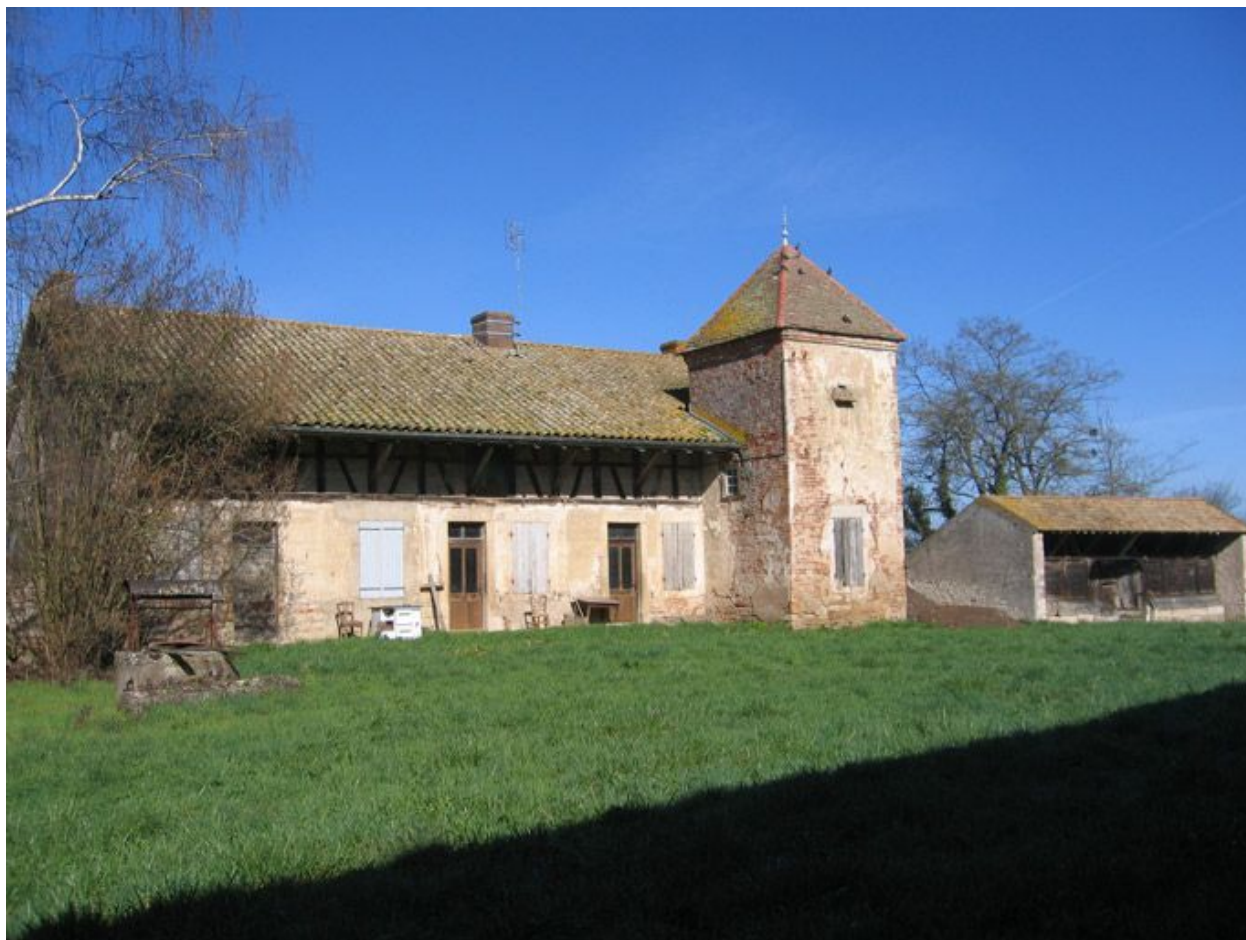
Vue d'ensemble de la façade de l'habitation.
