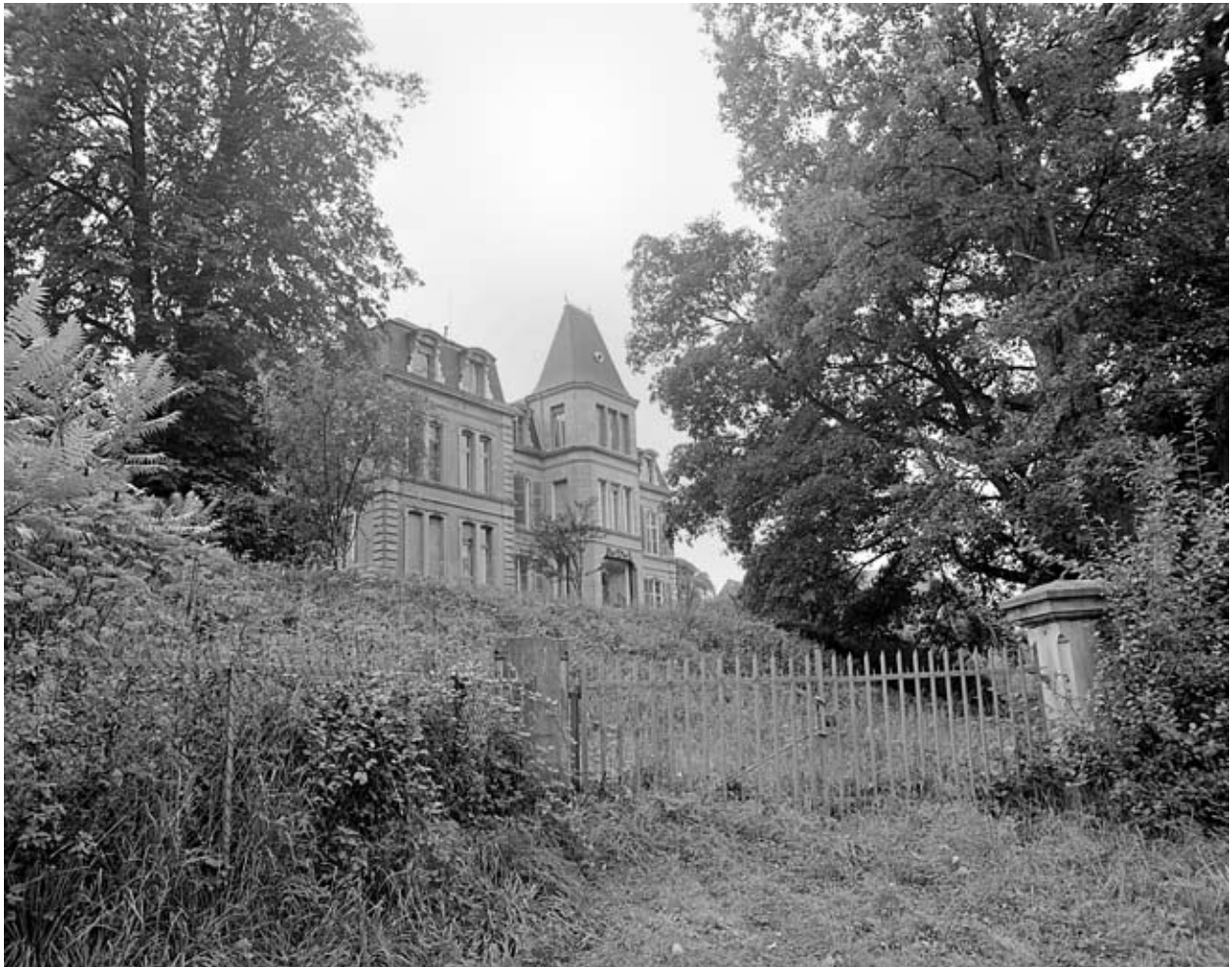
Façade postérieure en 1981.SRI. Enquête régionale sur les bâtiments industriels (1979-1981).
