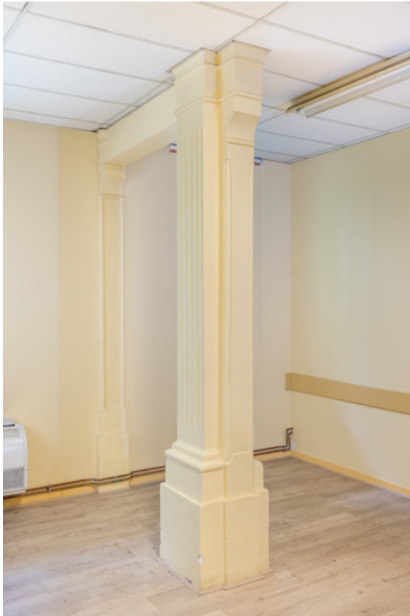
Pilier délimitant l'espace du chœur. Détail.
