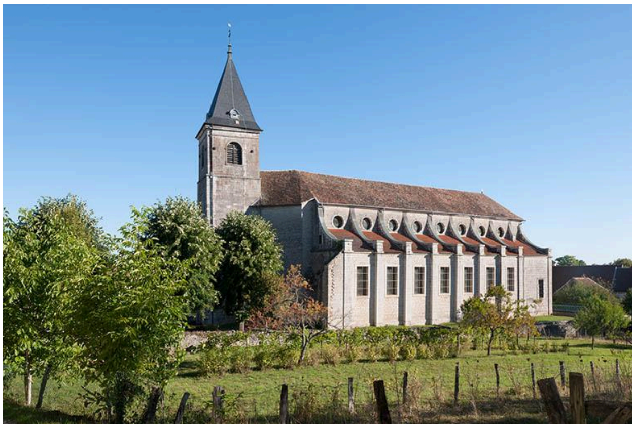
Vue sud-ouest de l'église
