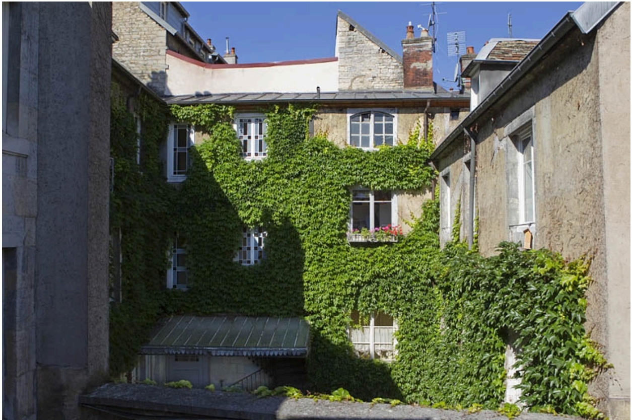
Vue d'ensemble de l'aile contenant l'escalier principal.
