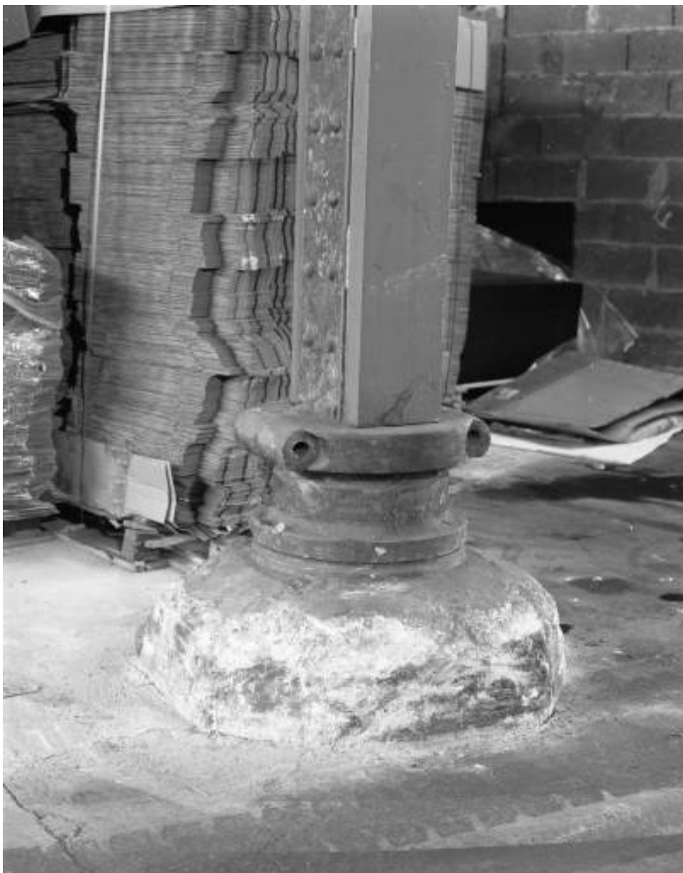
Ancienne fonderie. Base d'un pilier (fonte ?).
