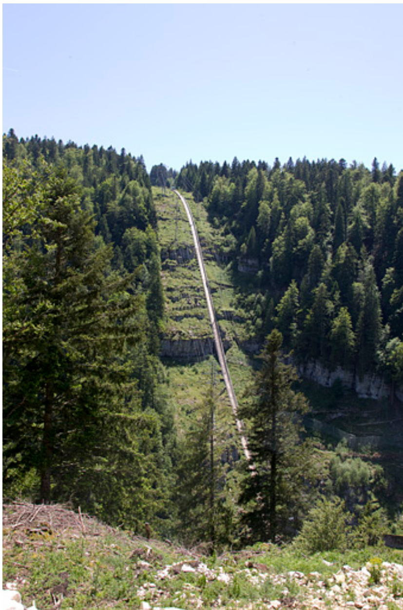
Centrale du Châtelot (commune des Planchettes, Suisse) : le funiculaire utilisé pour accéder au site.
