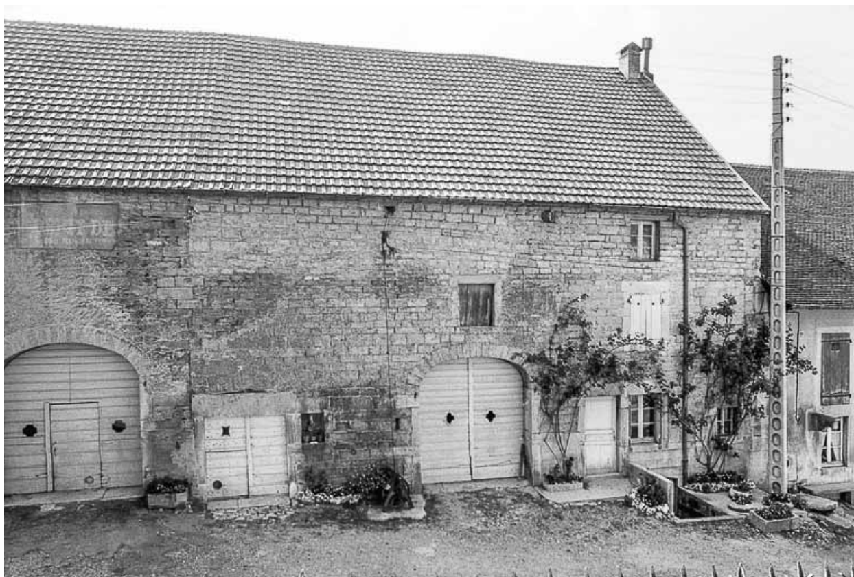
Ferme cadastrée D2 194 : façade antérieure.
