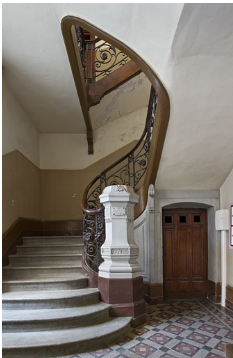
Logis principal, escalier dans oeuvre : vue d'ensemble.
