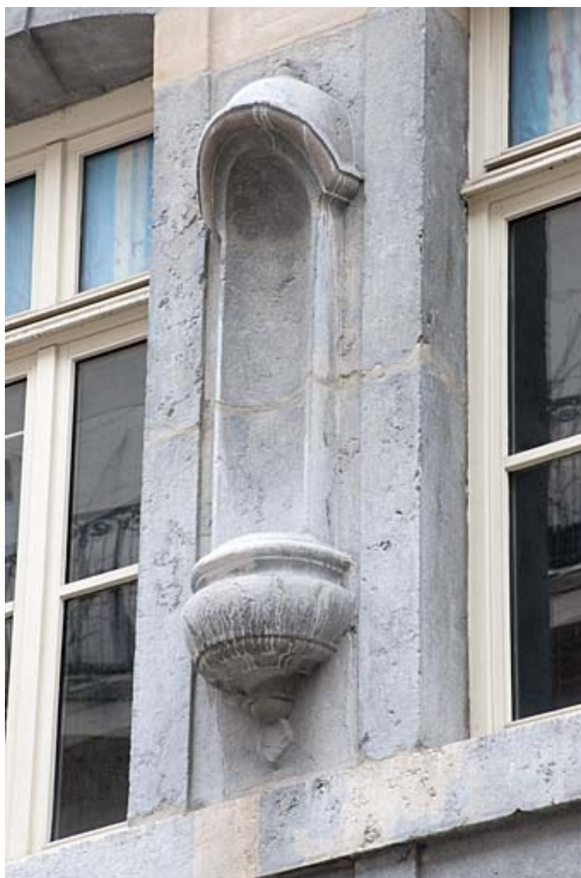
Façade sur rue : détail de la niche.
