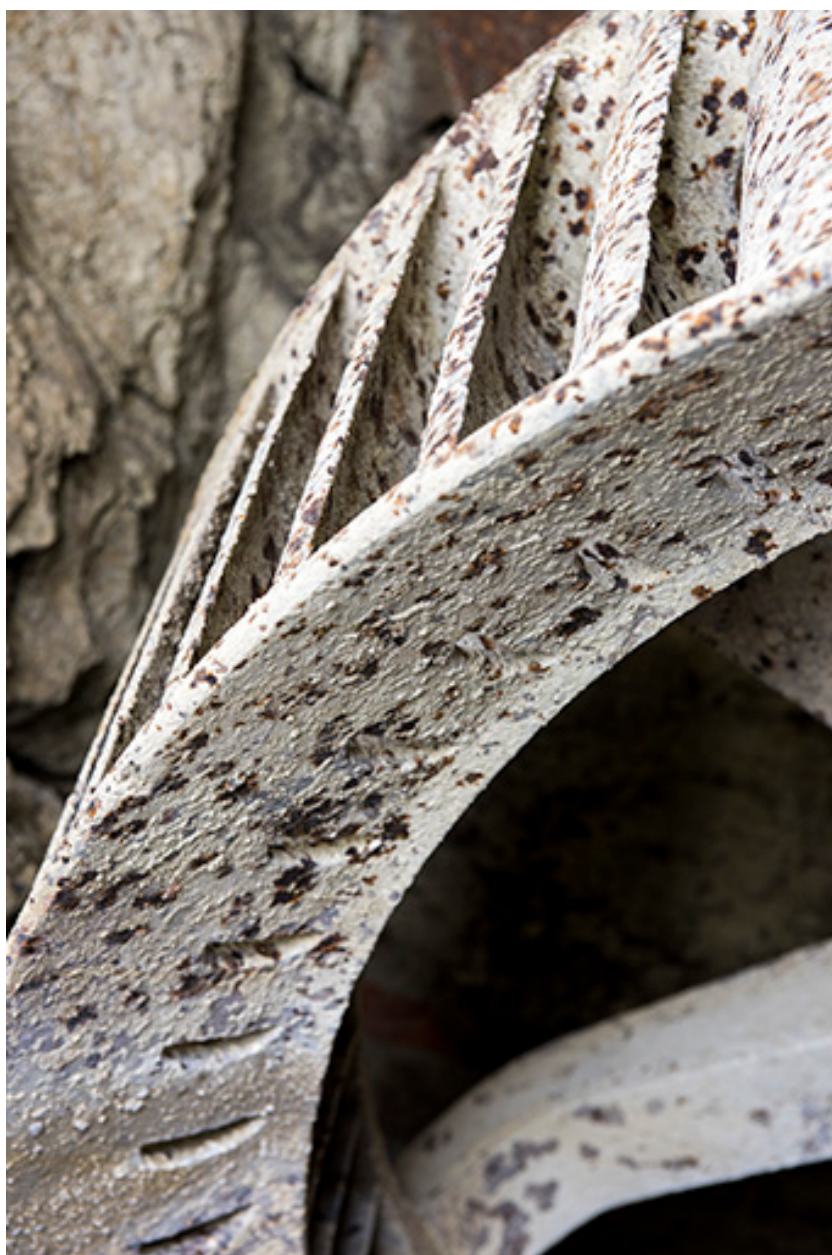
Usine : aubes de la turbine.
