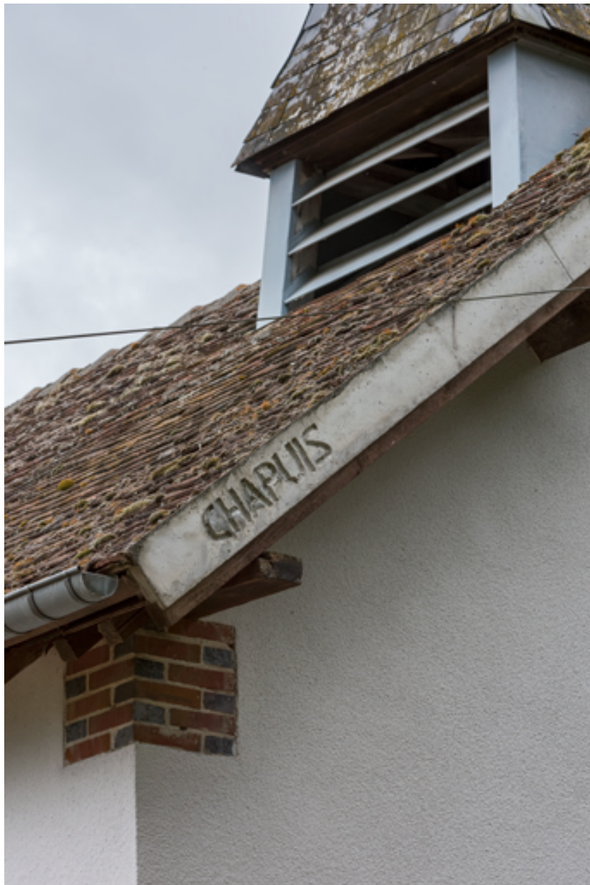
Rampant et rive de la toiture (détail).
