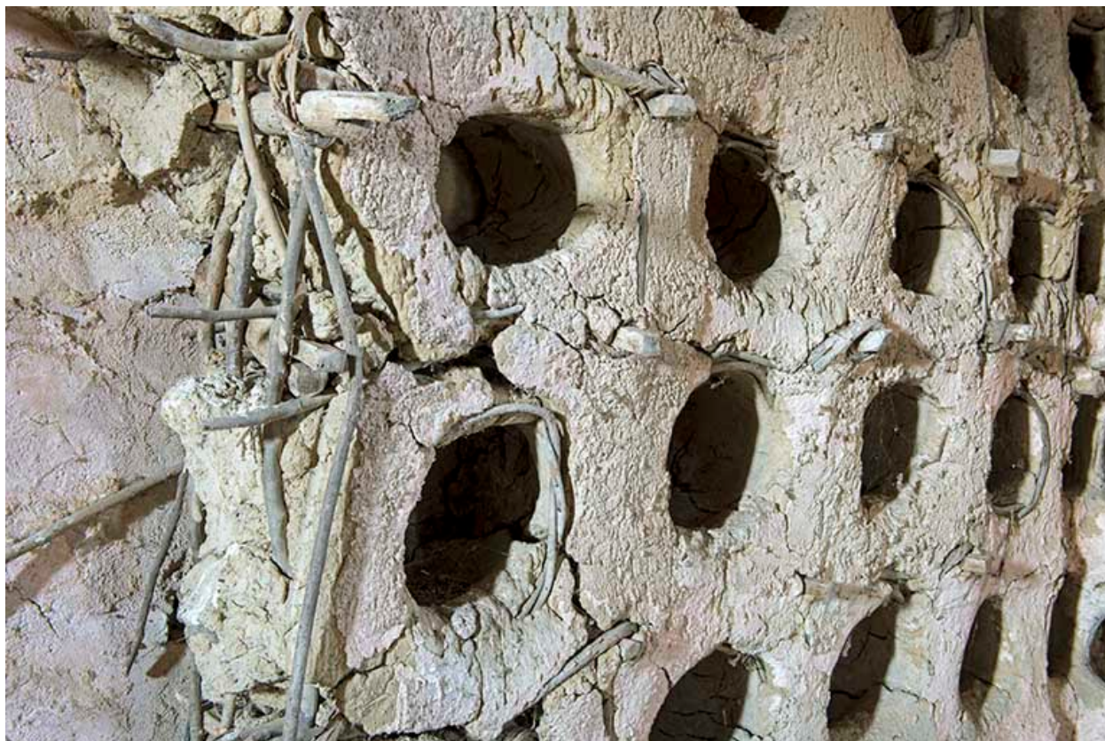
Détail sur la construction des boullins.
