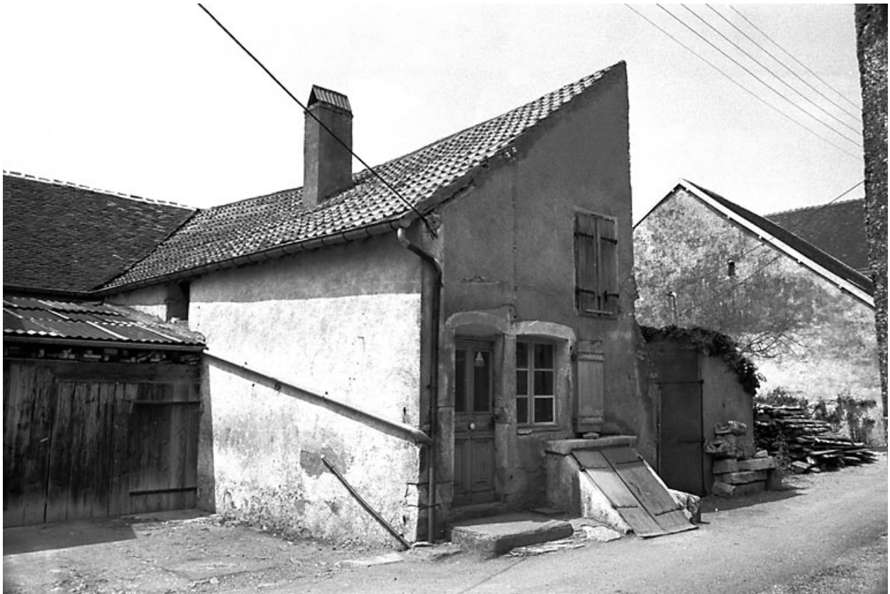
Maison située rue Granvelle : vue d'ensemble.
