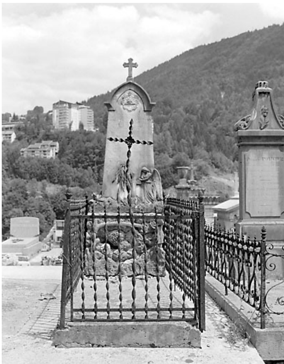
Vue d'ensemble, de face : grille de clôture.
