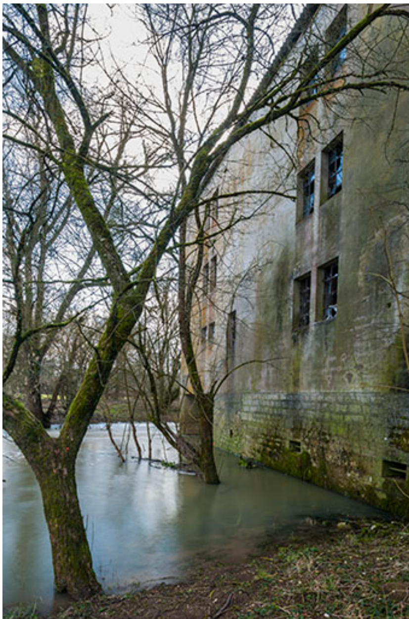
Façade nord du magasin industriel.
