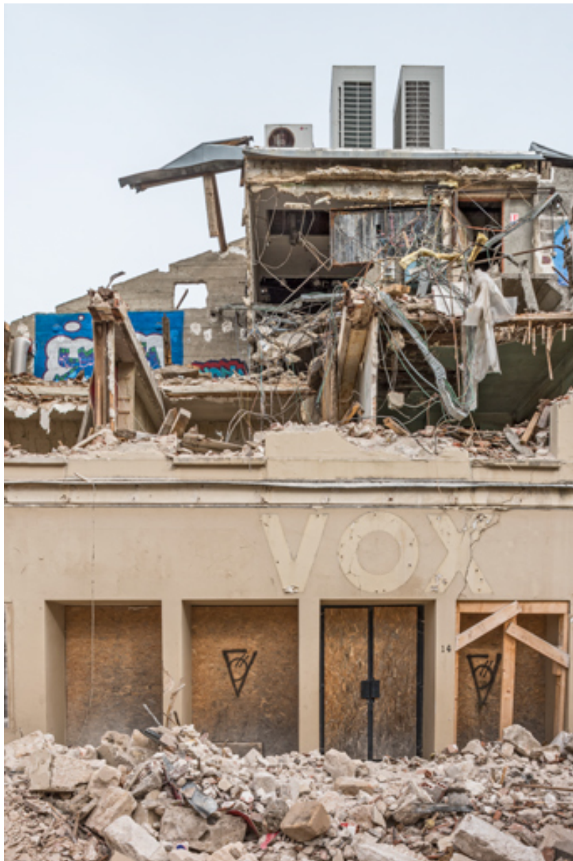
Cinéma Vox (14 rue Victor Guichard) en cours de démolition : entrée (22 mars 2023).
