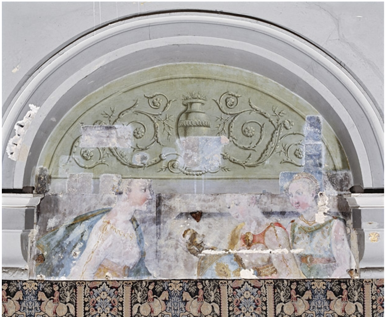
Chambre de l'Aigle, mur nord, partie ouest
