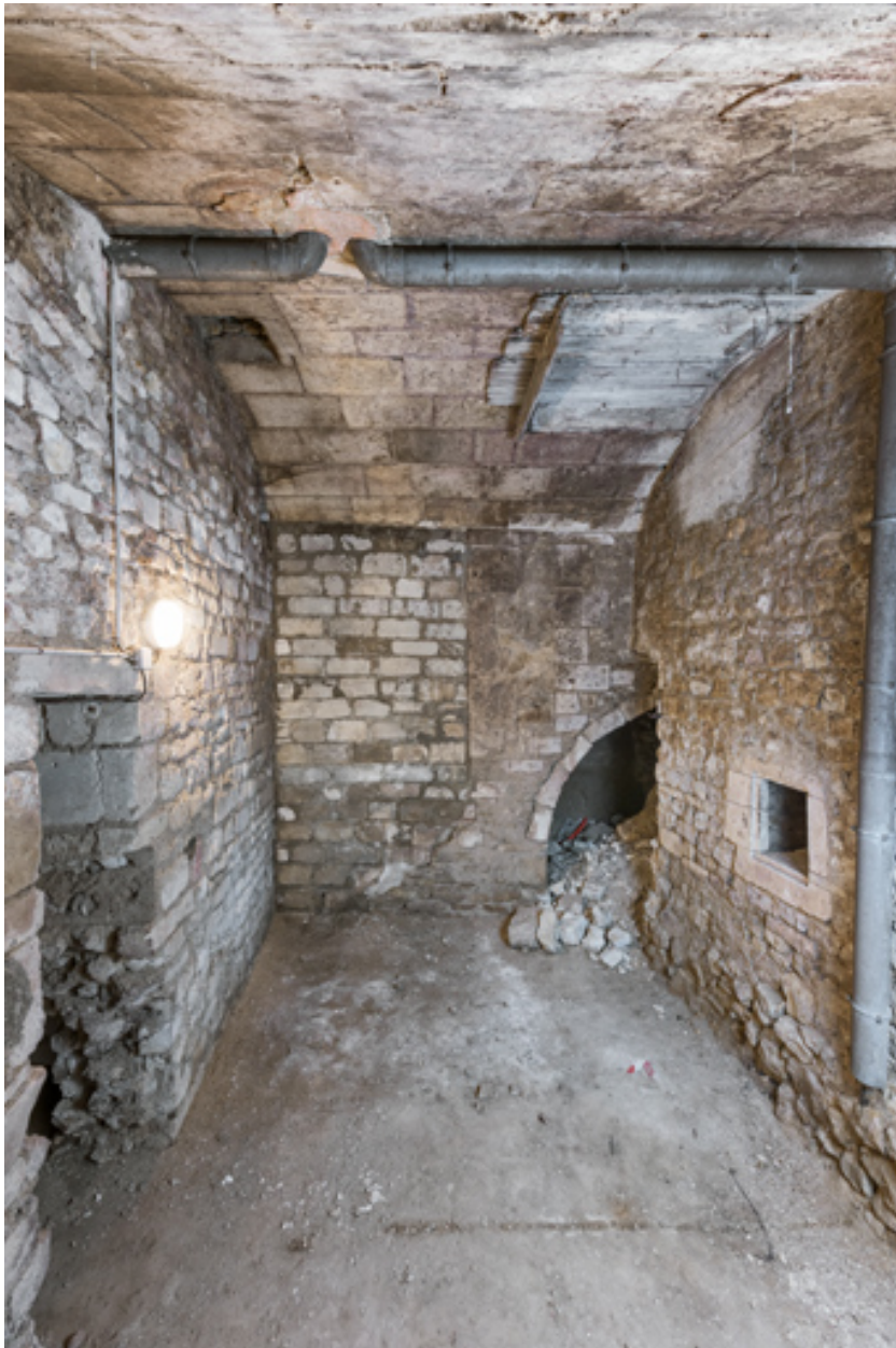
Caves sud : 1re pièce, depuis l'escalier au sud. Au fond, mur pouvant remonter au 12e siècle.
