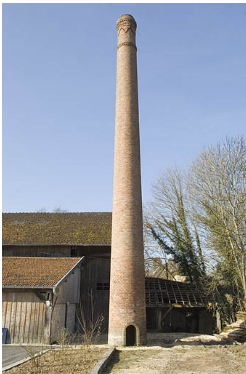
Cheminée depuis le nord.
