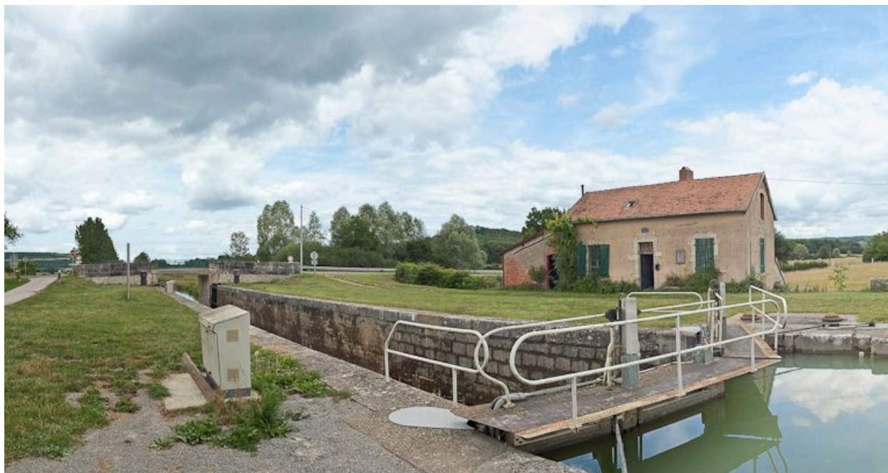
Vue d'ensemble du site d'écluse.
