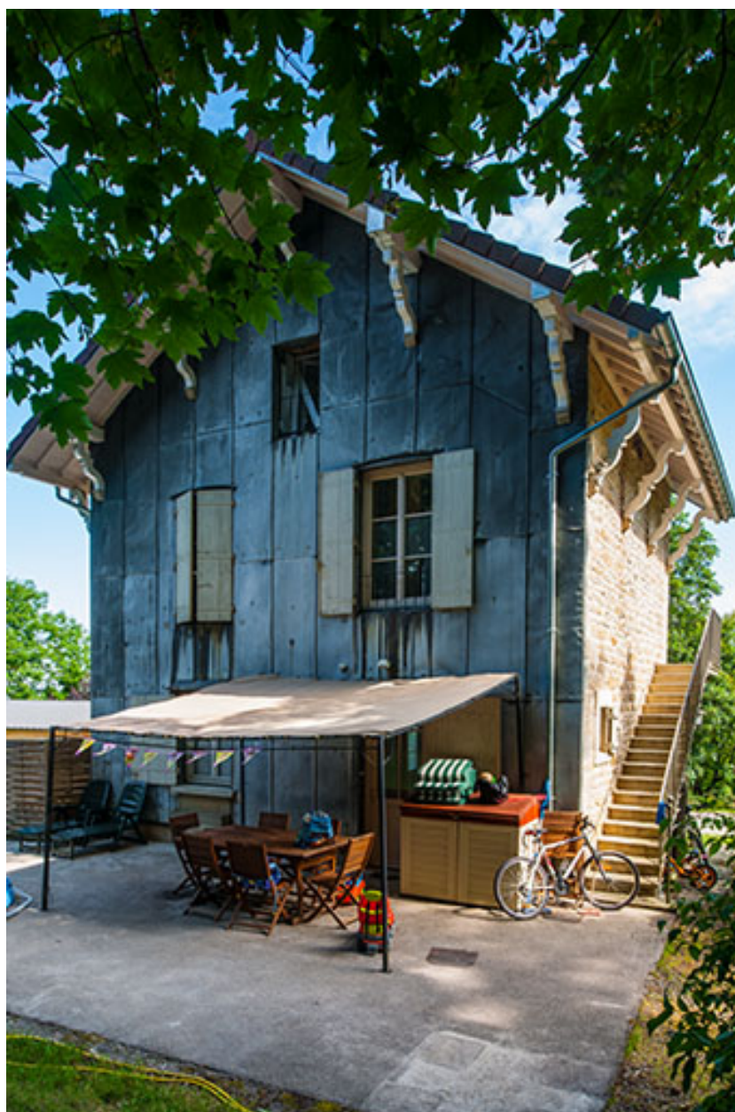
Villa Les Perrières : façade postérieure, logement.
